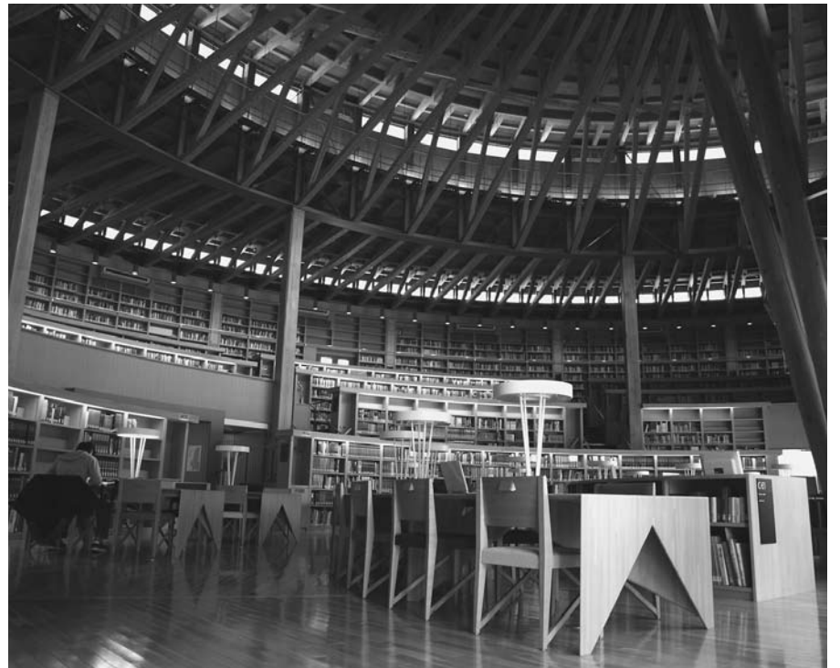
図書館は建築家・仙田満氏の設計で、「本のコロセウム」をテーマとした全国にも例を見ないユニークなデザインの建築物。秋田杉を使用し、伝統技術を生かした傘型屋根の開放的な構造となっている
