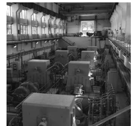
ポンプ設備は上下水道やかんがいなど、途上国の社会インフラ整備に役立っている。写真は、ウズベキスタンのかんがい施設のポンプ場
